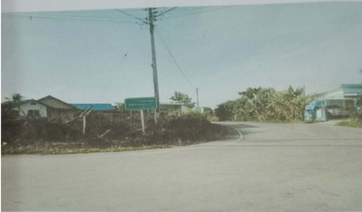
ภาพถ่ายการตัดต้นไม้ที่ขึ้นปกคลุมแนวสายไฟฟ้า
